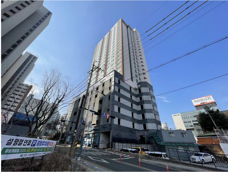
본건 외부 전경
