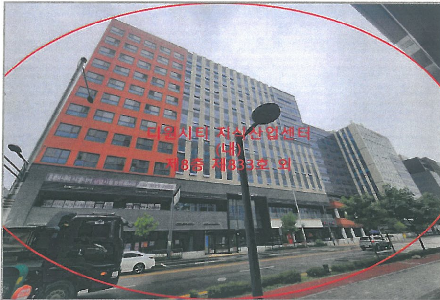
대상물건 전경 - 남동측에서 촬영
