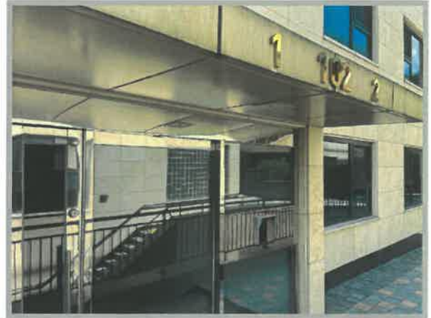
[일련번호(나),(다) 1층 출입구]
