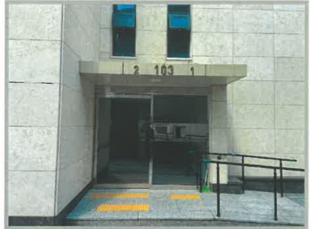
[일련번호(라),(마) 1층 출입구]
