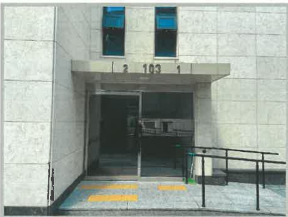
[본건 1층 출입구]
