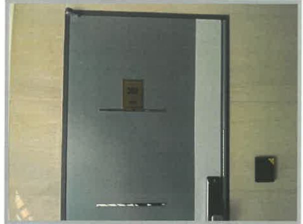
[일련번호(나) 1층 출입구]
