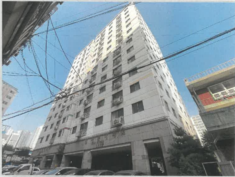
[본건 건물 남측 전경]
