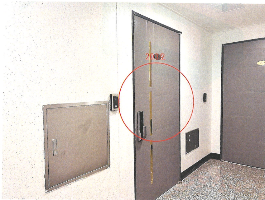
【 대상물건 전경[203호 복도에서 촬영] 】
