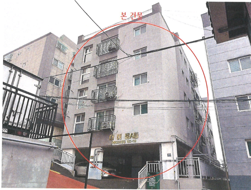
【 대상물건 전경[북동측에서 촬영] 】
