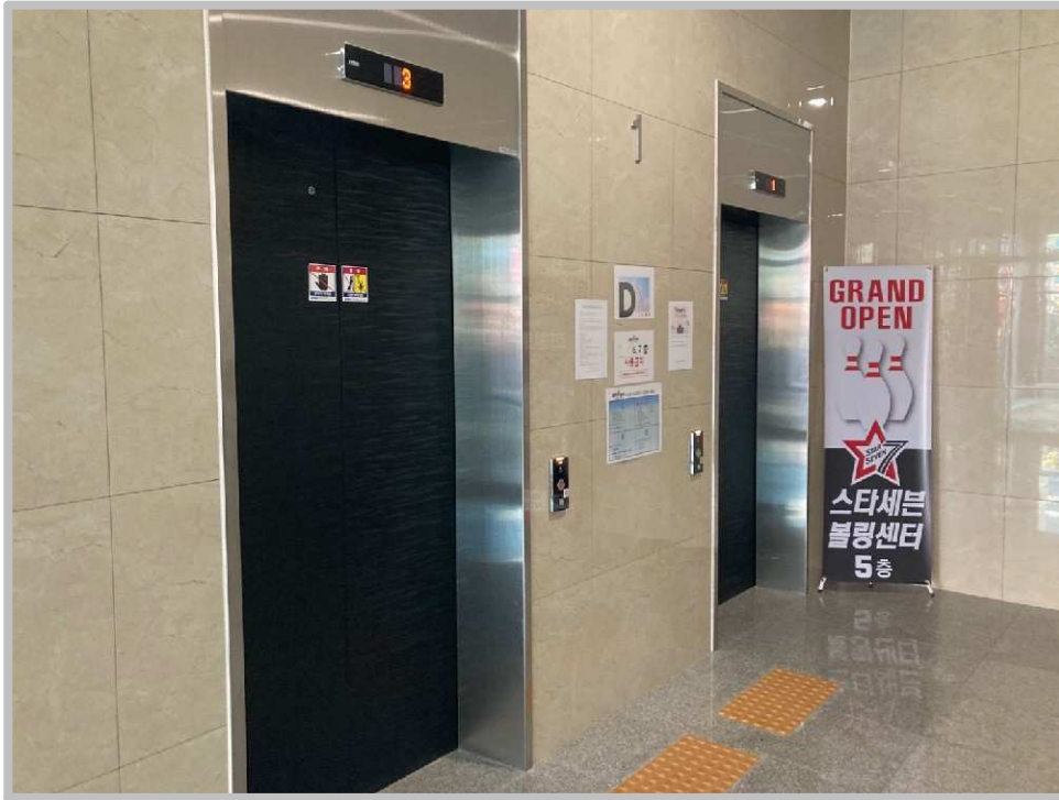
【 본건 승강기 설비 전경 】
