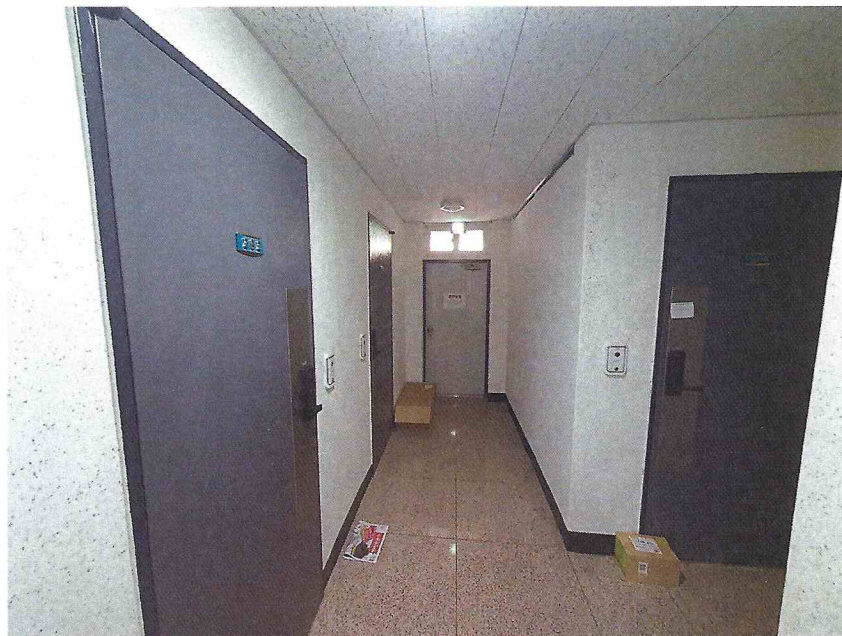
【 2층 복도 전경 】
